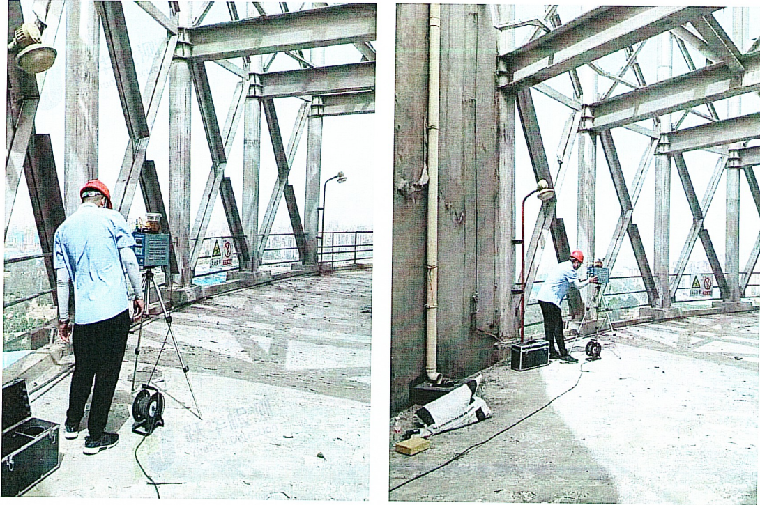
尿素造粒塔楼顶部○1
